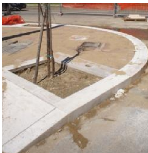
Borqo Marni Sud – Pescara 2005 (cantiere)
